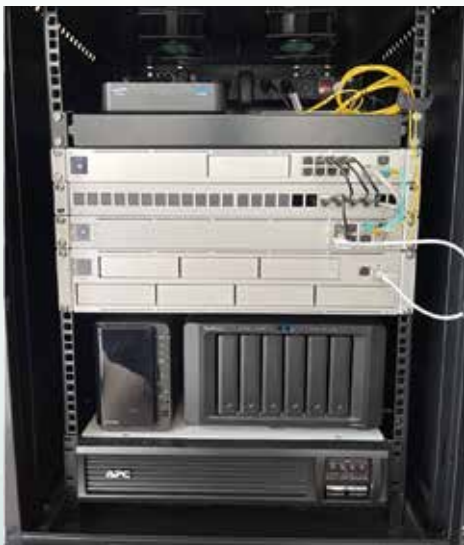
機櫃配置圖。由上倒下包含中華電信小烏龜、交換機、監控設備、NAS(Network Attached Storage 網路儲存伺服器) 以及不斷電系統
